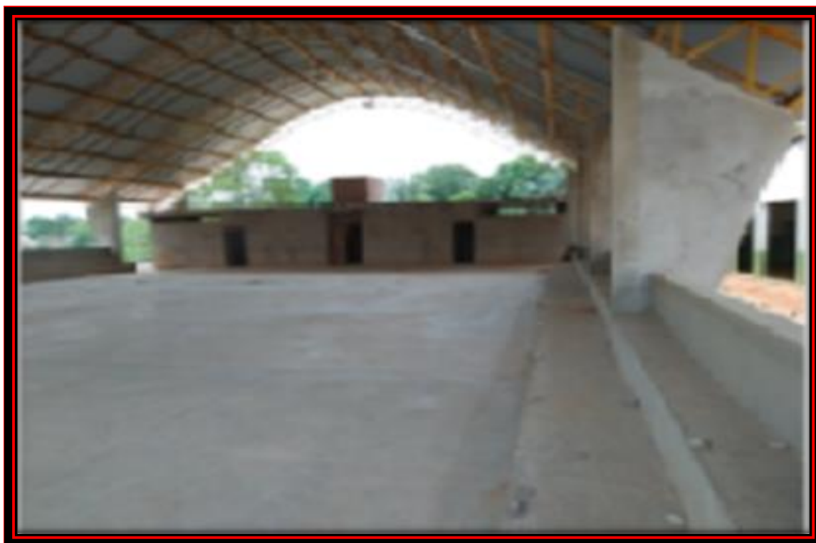
Figura 7 – Mosaico Ginásio Poliesportivo em Construção
