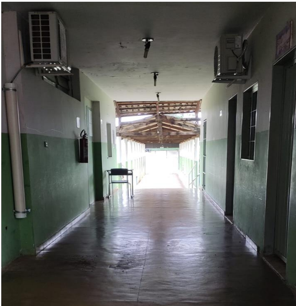
Figura 3 – Corredor Principal de Acesso a EMMGT
