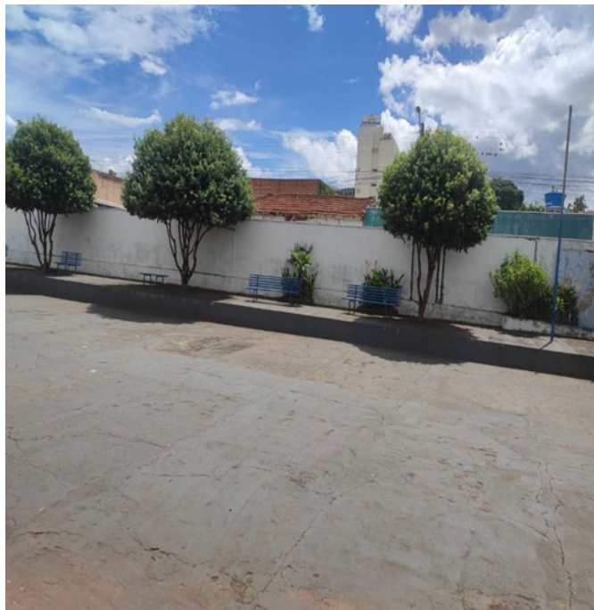
Figura 4 – Pátio interno descoberto
