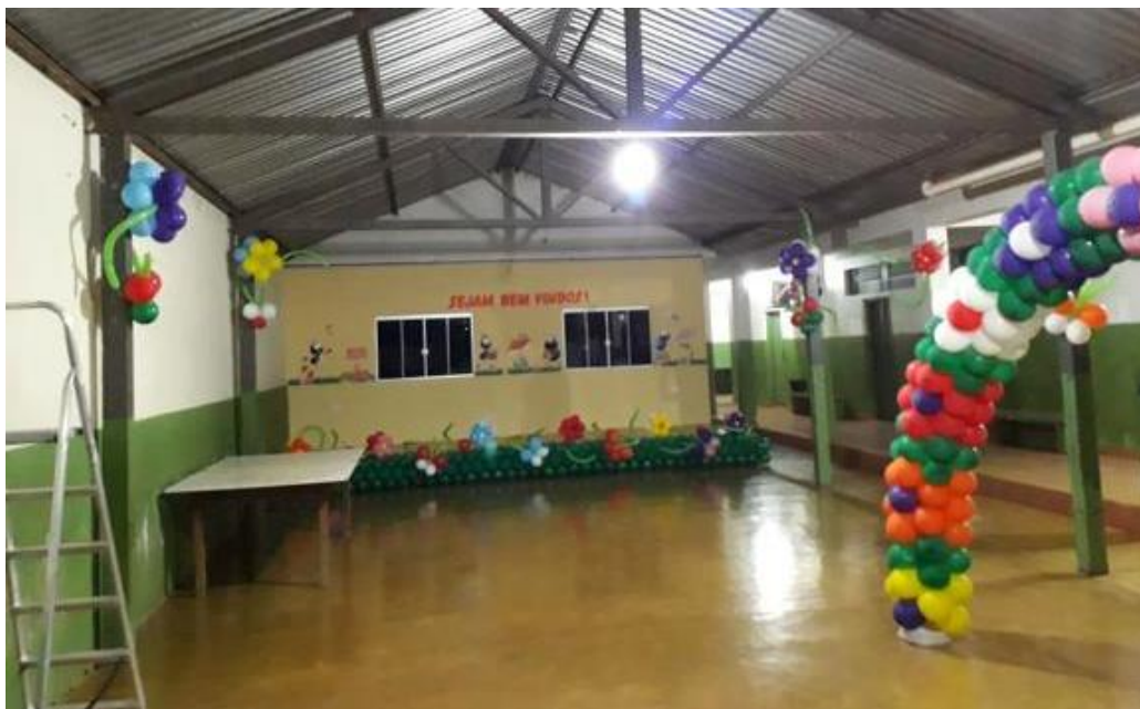
Pátio coberto (entrada)
