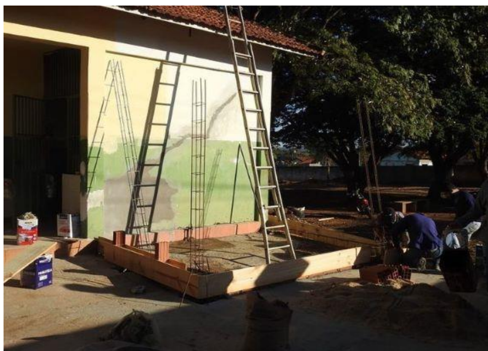
Reforma (construção da sala disciplinar)
