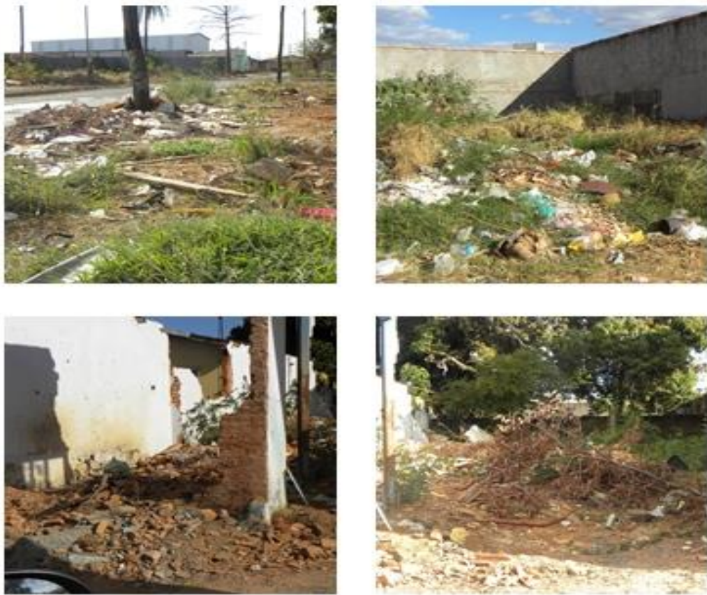
Figura 8 Áreas externas de imóveis propícios à ocorrência e proliferação de escorpiões com resíduos sólidos, tijolos, telhas; terreno baldio e frestas em paredes.
