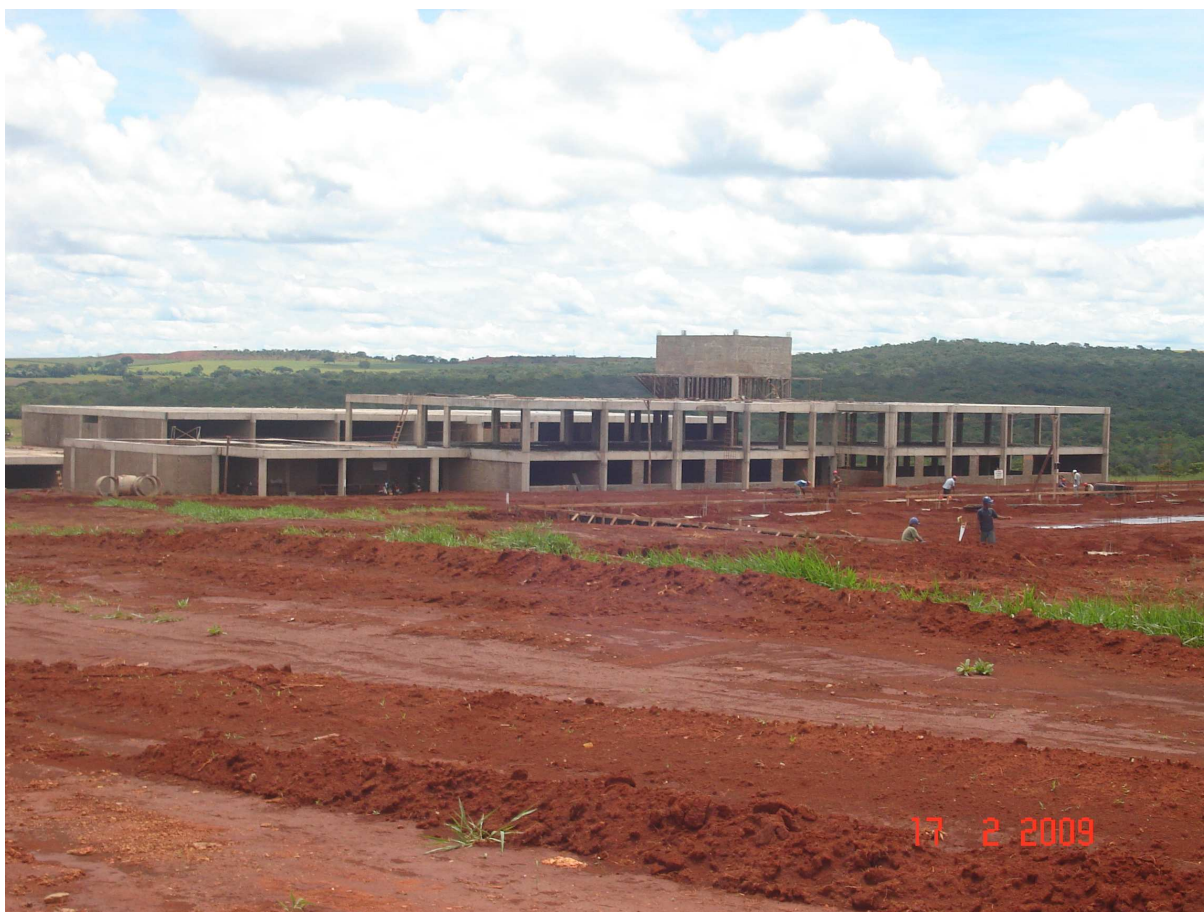
Foto 1.8 – Blocos em construção da Unidade de Jataí.
